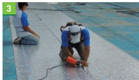
3 Se puede termosoldar rollo a rollo sobre la estructura o unir varios rollos en el piso y luego colocarlos, ahorrando tiempo de instalación.
