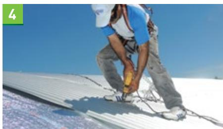
4 La membrana se fija conjuntamente con la chapa, con tornillos auto perforantes o ganchos. Gracias a la memoria elástica del material la espuma se cierra en el punto de fijación impidiendo el pasaje de agua o vapor.
