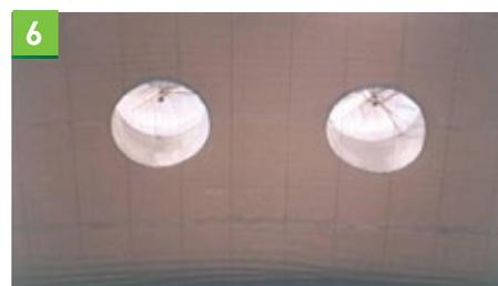
6 Se pueden instalar artefactos de iluminación, extracción, etc. perforando la membrana una vez finalizado el trabajo.
