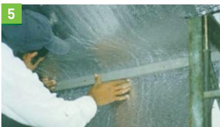
5 Se fija o se atornilla con listones o perfiles un lateral de la membrana al muro o a la estructura existente. Luego se tensa la membrana suavemente y se fija el segundo lateral repitiendo el proceso.
