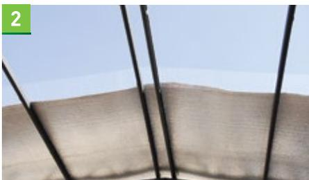
2 Si ud. compró un aislante NET, comience en este punto. Se presenta el rollo en el mismo sentido que las chapas de la cubierta. Se coloca el segundo rollo paralelo al primero superponiendo los solapes para hacer la unión por termosoldado.
