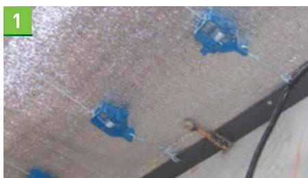
1 Se colocan alambres galvanizados, tensados perpendicularmente al sentido de las chapas. La separación entre alambres deberá modularse entre 40 a 60 cm.
