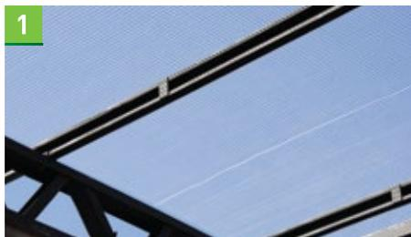
1 Sobre las correas colocar la RED 2x2 ISOLANT en el mismo sentido que la chapa. La RED 2x2 debe tensarse y luego fijarse con tornillos auto perforantes. En la unión, los rollos se solapan lateralmente de 5 a 10 cm, sin necesidad de unirlos entre sí, logrando el soporte necesario para una adecuada terminación.
