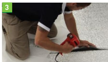
3 En estos casos es conveniente termosoldar varios rollos en el piso y luego instalarlos alineándolos a la estructura existente.
