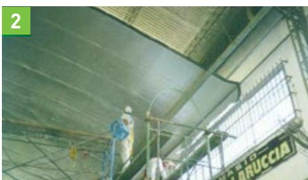
2 Los rollos se colocan pasándolos alternativamente por arriba y por debajo de los alambres, para evitar que la membrana flamee.
