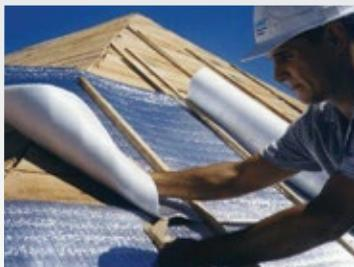
El termosoldado es la forma más efectiva y limpia de efectuar la unión de nuestras membranas, evita el uso de cintas o adhesivos, facilitando así la colocación y mejorando la terminación estética.
